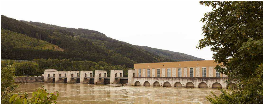
Abb. 5-1: Blick donauaufwärts zum Kraftwerk Jochenstein mit den Schützen der Stauehranlage links und dem Maschinenhaus rechts im Bild (Foto: VERBUND).
